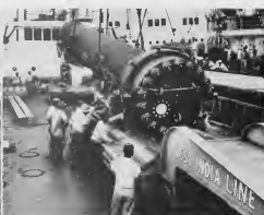
THE AMMONIA converter's 120-ton mass is transferred from the Pericles to the Inagua Wave, a converted LSM. E CONVERTIDOR di amoníaco di 120 ton ta wordé descargá for di Pericles pa Inagua Wave, un barco di desembarque.
